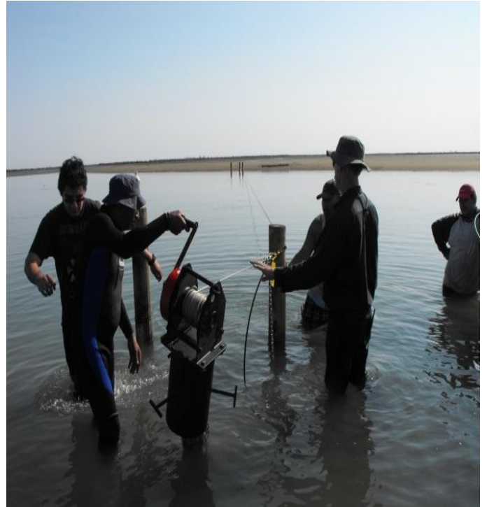
Figura 3. Terry Rehn y Romeo Vázquez en el momento de instalar el sistema de línea dinámica en el Estero La Santa Cruz, Sonora. A la derecha se muestra el tensado de una línea.
