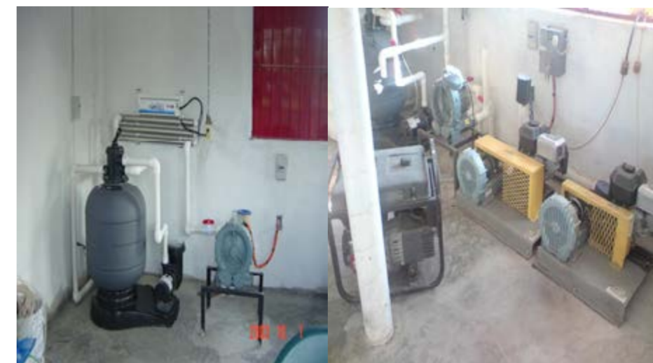
Foto 2. Sistema de recirculación acuícola básico para la producción de Tilapia con sistema de soporte de energía.
